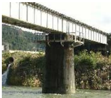
図1 A橋脚全景
