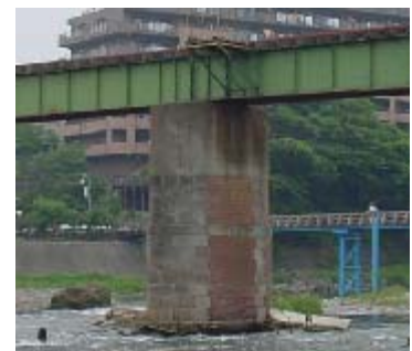
図3 C橋脚全景
