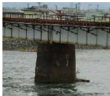
図2 B橋脚全景
