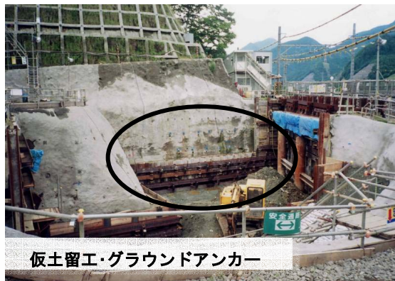
写真-1 1次対策施工状況
