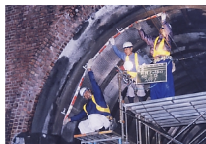
写真5 ステンレスメッシュ施工後
