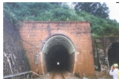
写真1 内方山トンネル(上)
