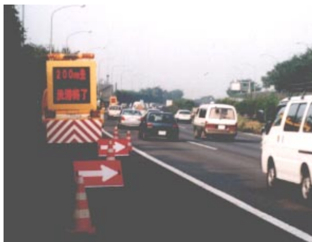
写真-1 上流側 LED 標識車配置状況
