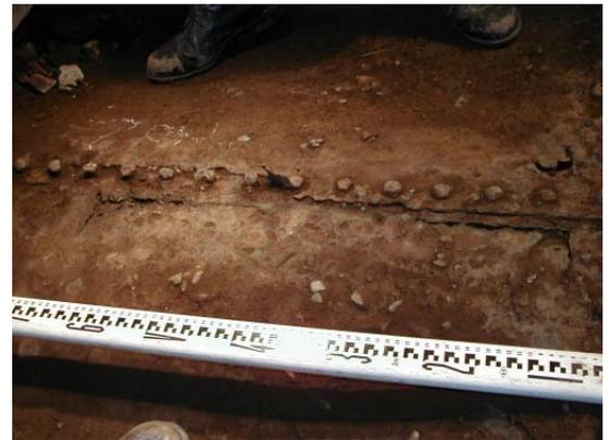
写真-1 バックルプレートの亀裂
