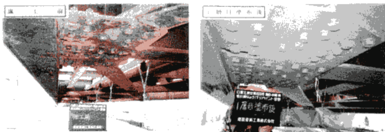
写真4 塗装工事過程（左：施工前、右：1層目塗布後）
