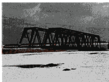
写真1 豊川橋りょう
