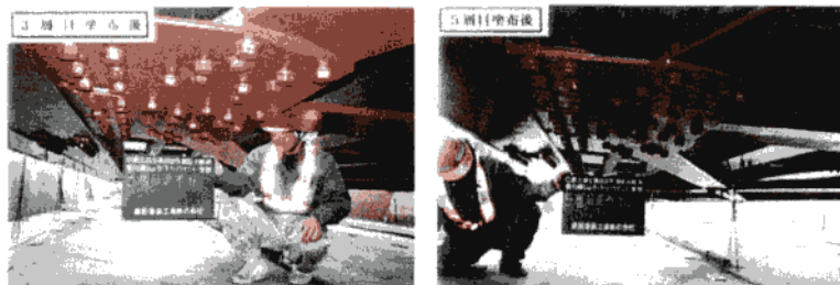
写真5 塗装工事過程（左：3層目塗布後、右：5層目塗布後）
