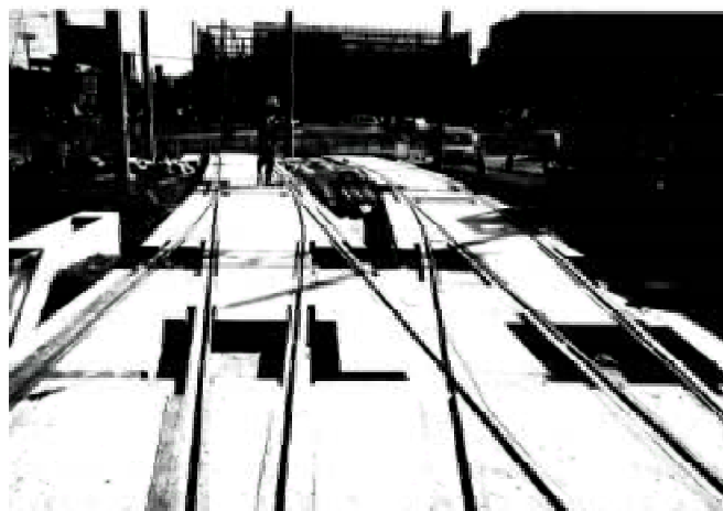
図2 分岐器の施工状況
