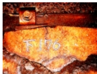
写真 2.1 浮き・亀裂
