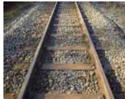
図2：直線区間に試験敷設したスチールまくらぎ
