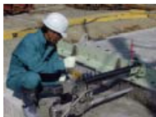
写真3 治具Aによる削孔
