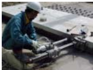
写真1 従来方法による削孔
