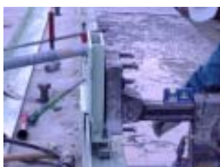
写真5 治具Bによる削孔。
