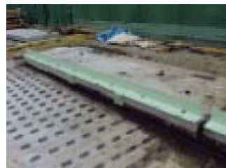
写真2 台座板およびレール
