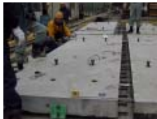
写真7 スラブ横取り状況
