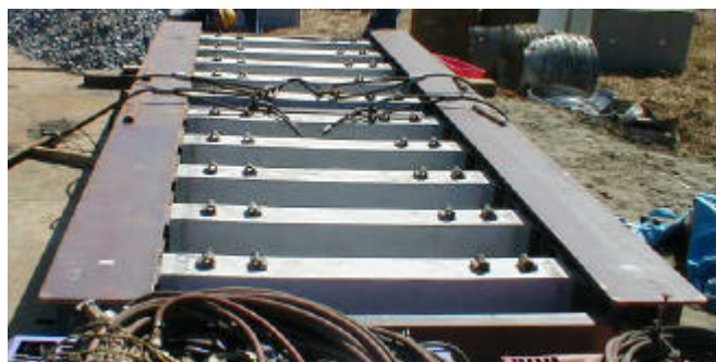
図4.工事桁全体図
