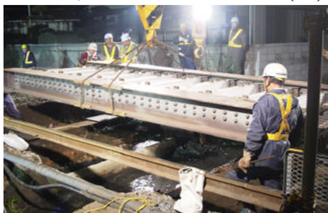
図5.施工状況(工事桁架設)
