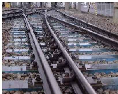
写真-2 施工後の状態
