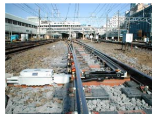
次世代分岐器試作品（大宮駅構内80イ）
