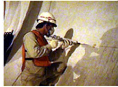
写真2 光ファイバー固定治具設置作業状況
