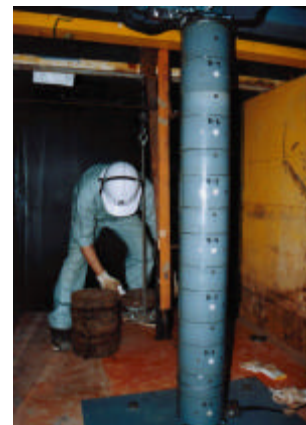
写真-1 静的載荷実験状況
