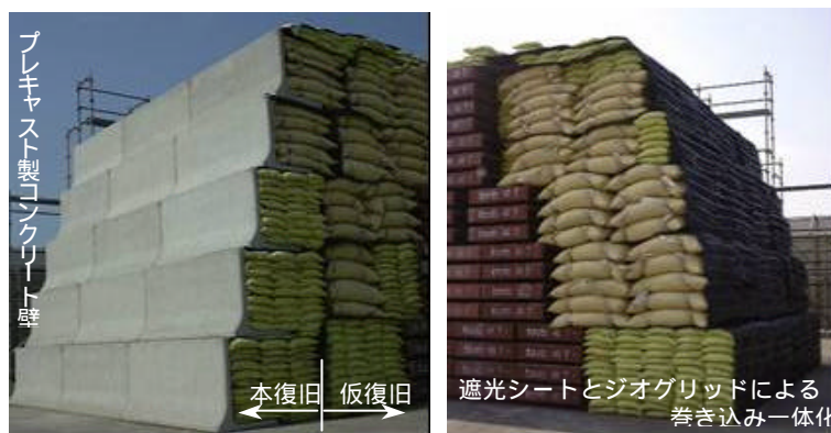
(a) 本復旧断面 (b) 仮復旧断面 写真—1 土のう積み試験盛土
