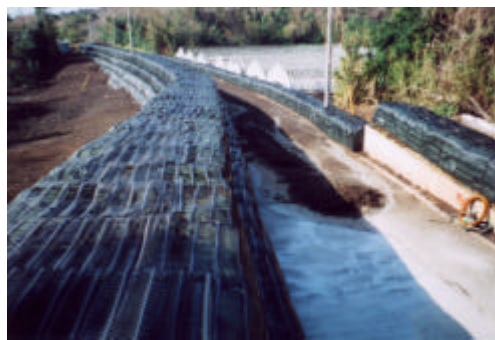
写真—5 完成後の導流堤
