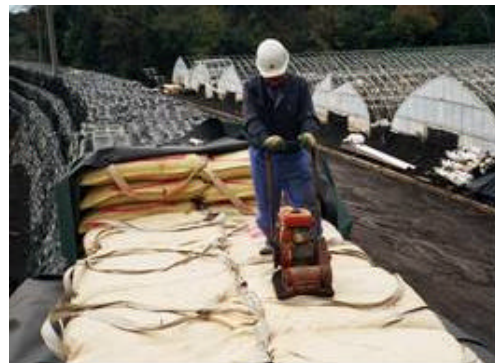
写真—4 振動プレートによる転圧状況
