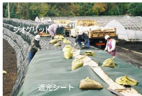
写真 - 3 遮光シートとジオグリッドによる巻き込み工事の様子
