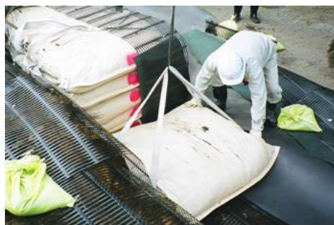
写真 - 2 土のう積み工事の様子
