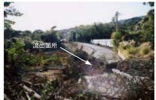
写真-1 泥流による村道流出の状況
