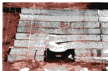
図-8 土嚢全撤去後（ケース1）
