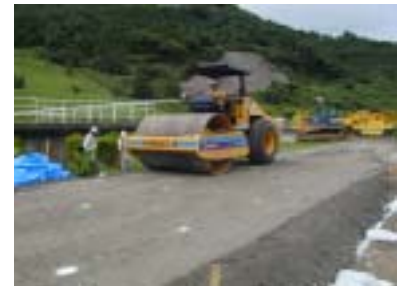
写-1 現場転圧試験実施状況
