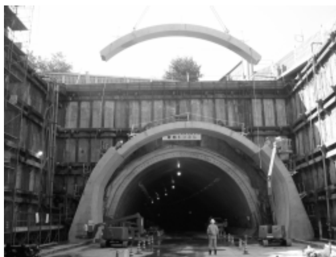
写真-1 施工状況
