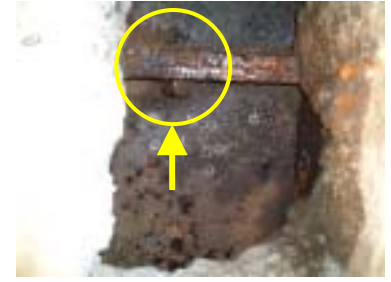
写真 2.3 ボルトナット（E-PL 部）
