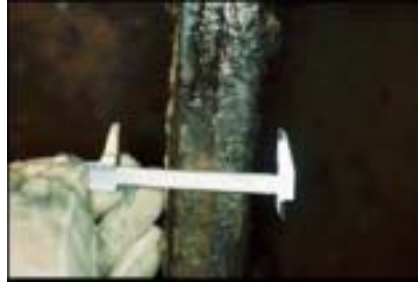
写真 2.2 リング継手部（主桁連結部）
