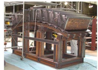
写真-2 鋼枠設置状況
