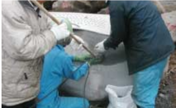
写真 - 2 破碎エレメント挿入状況
