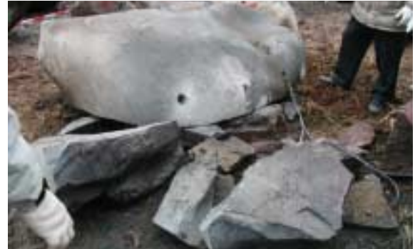
写真 - 3 破碎後(破碎孔1孔の場合)の転石
