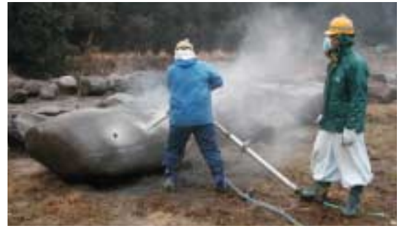
写真 - 1 削孔状況
