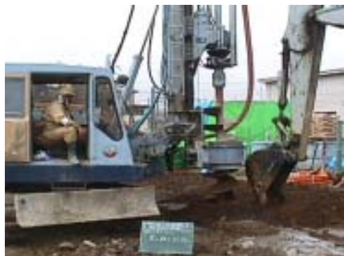
図4 改良土壁施工状況
