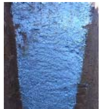
図5 改良土壁（断面）
