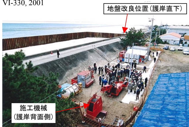
写真－1 施工状況
