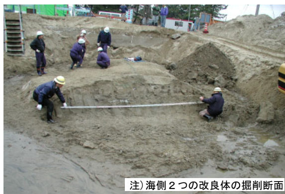
写真－3 改良体断面形状
