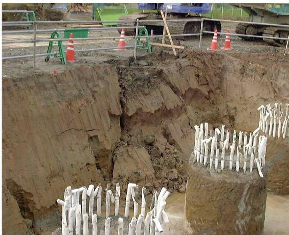
写真1 法面崩壊状況
