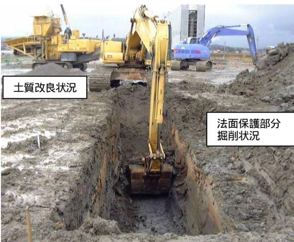
写真2 法面保護部分の掘削および土質改良作業状況
