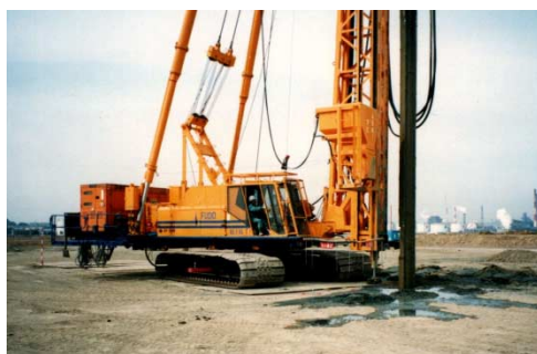
写真－1 施工状況
