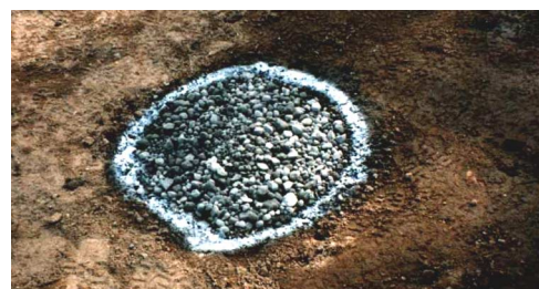
写真－2 造粒石炭灰杭頭
