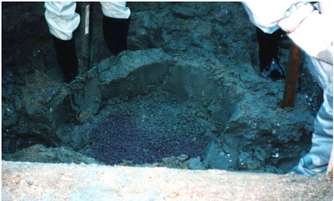
写真－4 掘削目視状況
