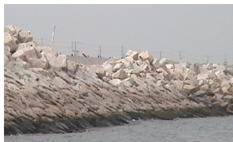
写真 - 1 被覆石の仮置き
