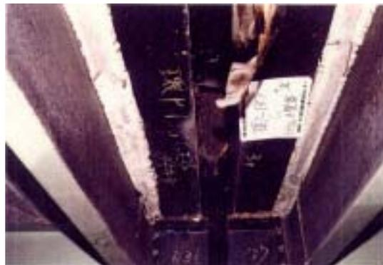
図-1 止水材の脱落
