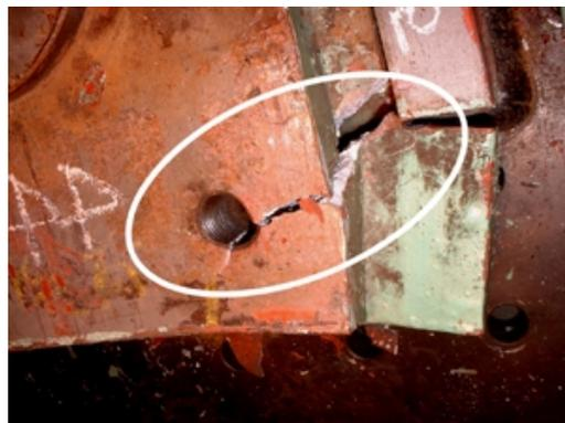
写真-1 下沓の破壊状況(Case-1)
