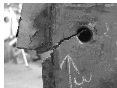
写真-3.1 橋軸方向（固定沓）
