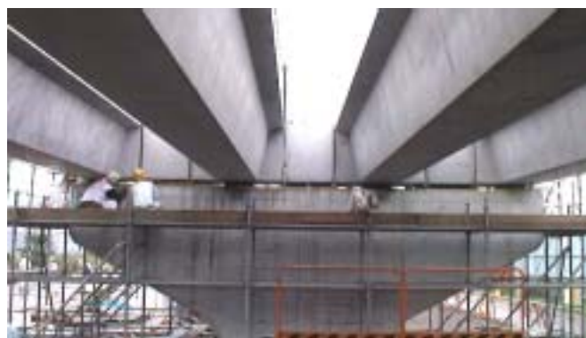
写真-1 PCU形桁架設状況
