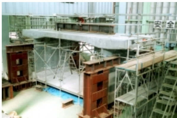
写真-1 実物大試験体の外観
