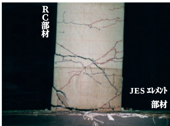
図3 ひび割れ発生状況
