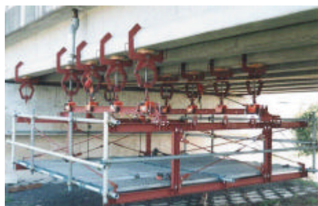
写真-1 簡易移動吊足場
