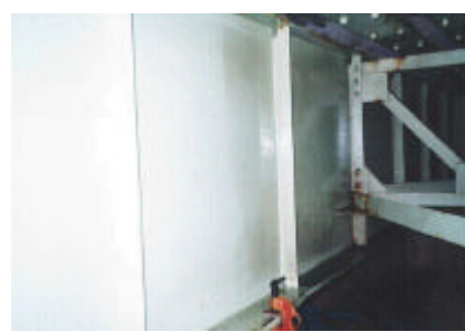
写真-3 洗浄前後の汚れの除去状況 (手前が洗浄後)
