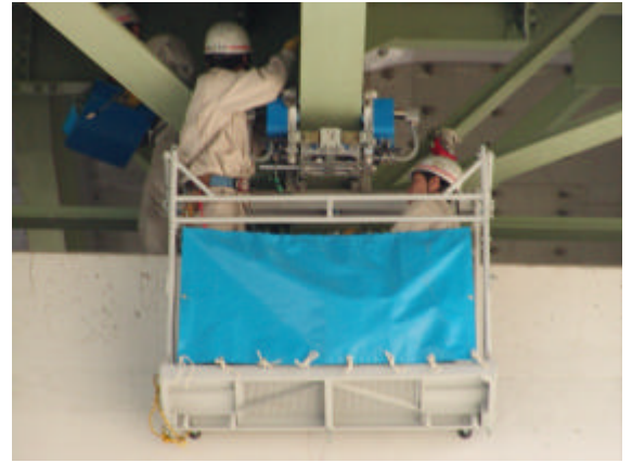
写真2 簡易足場による点検ロボットの設置
