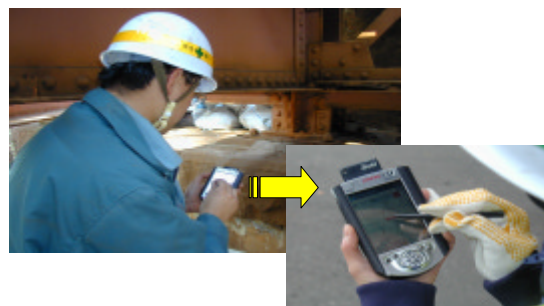
図-5 現場におけるプロトタイプ実証実験風景
