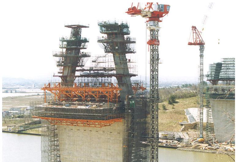
写真-2 主塔施工状況
