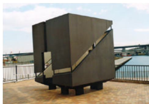
写真2 設置2年後の実構造物写真（モニュメント） （瀬戸内海より離岸距離約30m／神戸）
