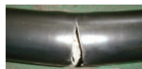
写真-3 完全に破断した状況 ( H=3.0\text{m} )
