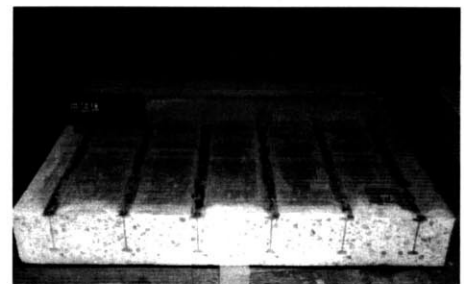
写真3 底板除去後の状況(裏面)
