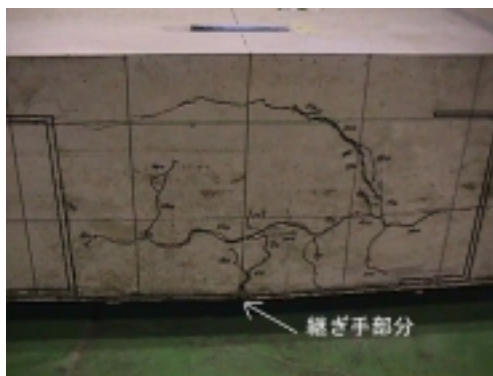
図7 破壊状況（TYPE B-2）
