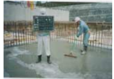
図4 (b)床部の塗布状況
