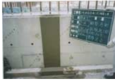
図4 (a)壁部の塗布状況
