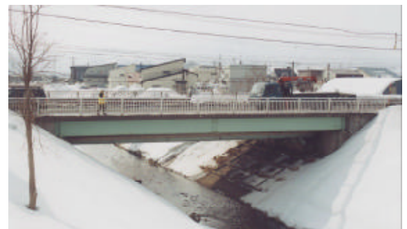
図-1 大浜中橋の全景
