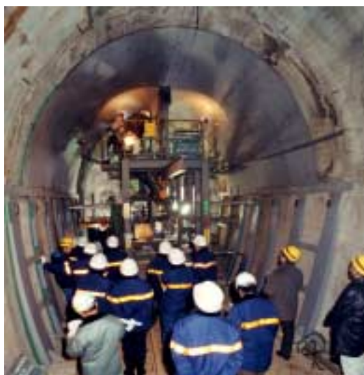
写真-2 廃線トンネル試験
