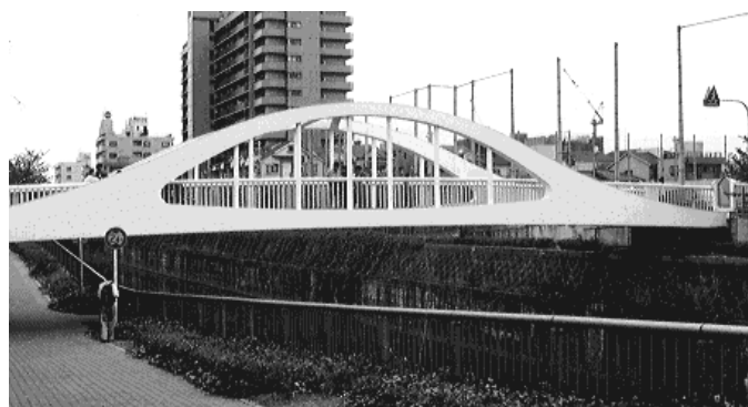
写真 1 塗装LCCを試算した橋梁の外観
