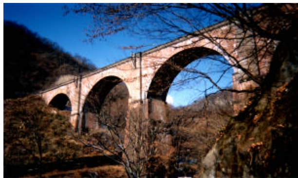
写真 - 2 碓氷第三橋梁（めがね橋）
