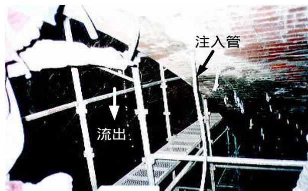
写真-3 めがね橋注入状況
