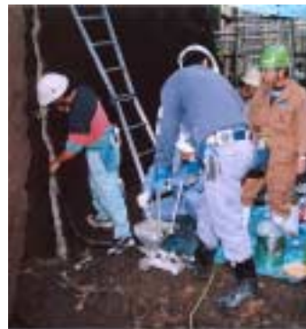
写真3 亀裂充填材の注入
