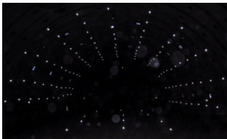
図1 ターゲットを設置したトンネル
